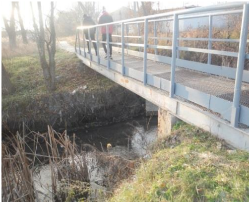
Рис. 4. Огорожа (перила) мостової споруди
